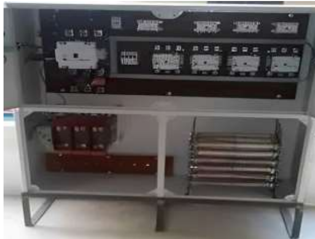
Fig. 2.5: रोटार रेझिस्टन्स स्टार्टर (Rotor Resistance Starter)
