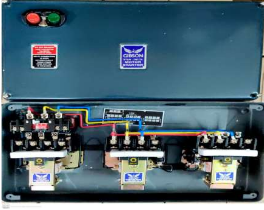
Fig 2.4 स्टार-डेल्टा स्टार्टर (Star-Delta Starter)
