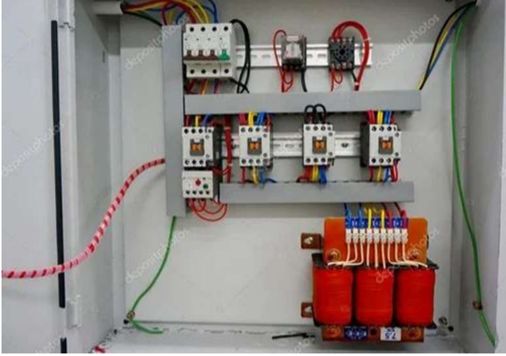
Fig. 2.3: ऑटो-ट्रान्सफॉर्मर स्टार्टर (Auto-transformer Starter)
